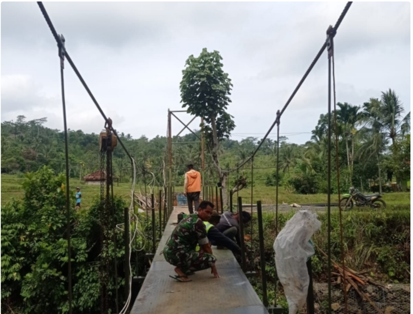
Kpt Arm Witono: Pengerjaan Jembatan Gantung Sudah 80%
